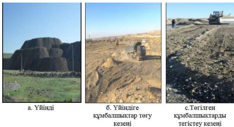
1 сурет – Үйіндіде техникалық рекультивация жүргізу кезеңі
