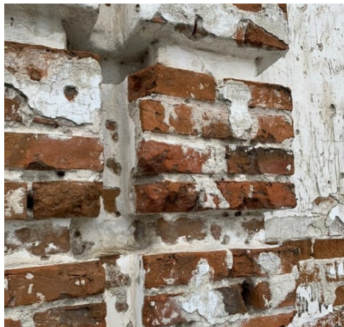
Рисунок 3 – Фрагмент кладки наружной стены
