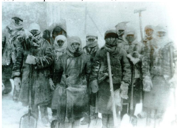
Фото 2. Женщины на расчистке строительной площадки Казахского металлургического завода, п. Самаркандский, 1943 год.
