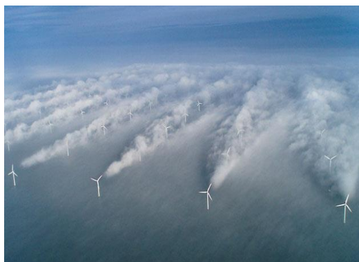
Рисунок 3 – Турбулентный след за ветротурбинами пропеллерного типа.
