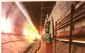
Рис. 4. Электронный тахеометр TS15, установленный в строящемся тоннеле метро.
