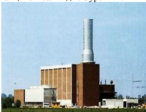
Сурет – 4 – Германияның Бермен қаласындағыжел энергиясын ауаны сығу арқылы жинақтап сақтау және пайдалану станциясы
