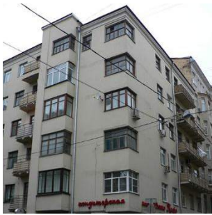
Рисунок 8. Жилой дом Госстраха. М. Гинзбург, В. Владимиров. Москва, 1926-27 г.
