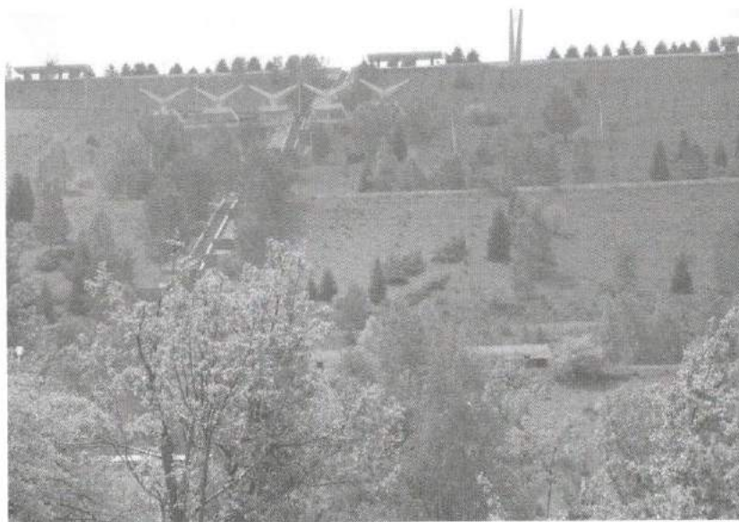
Рис. 1. Северный склон селезащитной плотины Медеу
