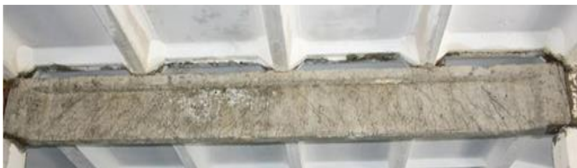
Рис. 1. Вид и состояния железобетонной балки под длительной нагрузкой
