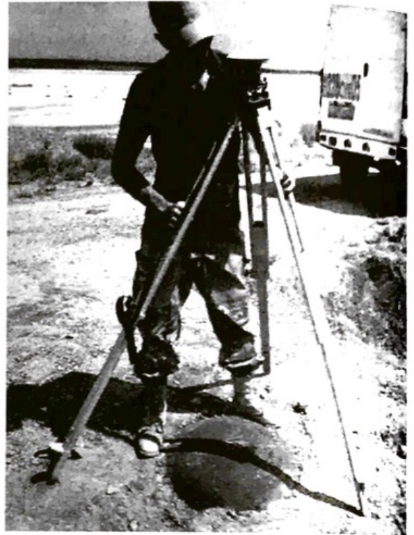
Рис. 3 – Производство спутниковых наблюдений на пунктах геодезического обоснования
