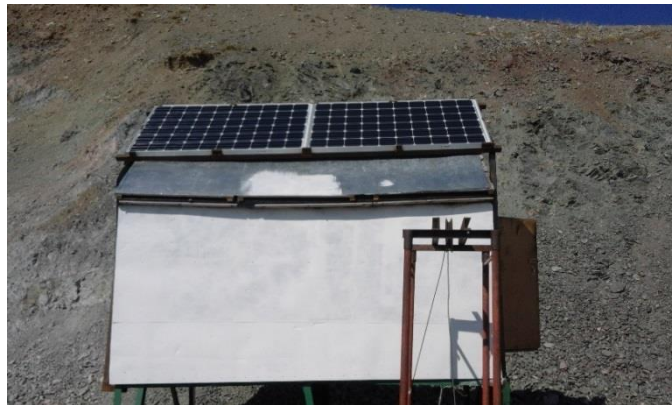
Рис.2. Специальное помещение с установленными в его крыше солнечными панелями
