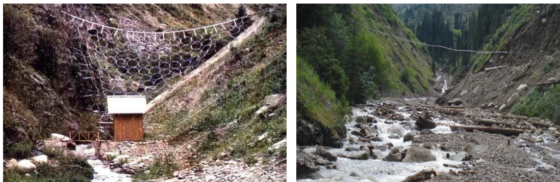
Рис. 5. Селезащитное тросово-сетчатое сооружение до и после селевого потока в 2013 году
