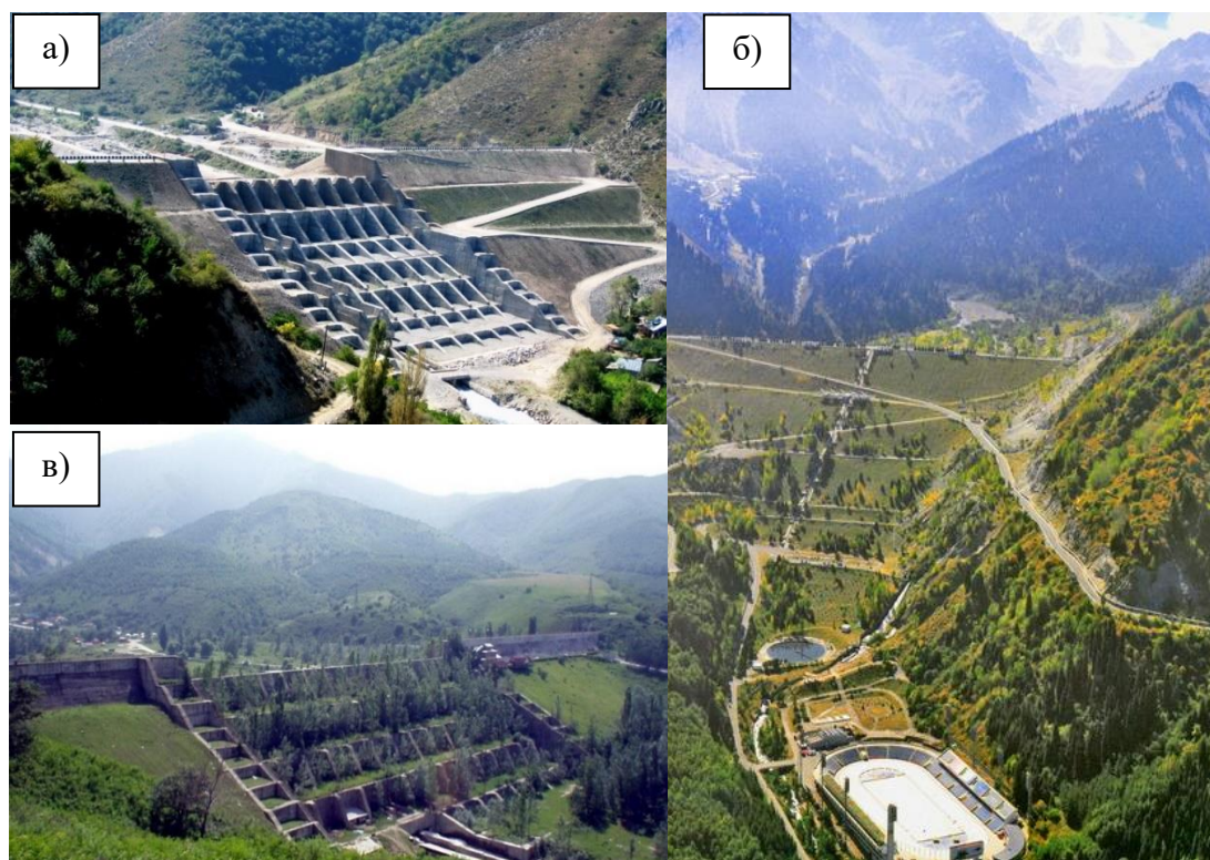
Рис 4. Селезадерживающие плотины в Иле Алатау: а) плотина в басс. р. Талгар; б) плотина Медеу в басс. р. Киши Алматы; в) плотина в бас. р. Улкен Алматы.
