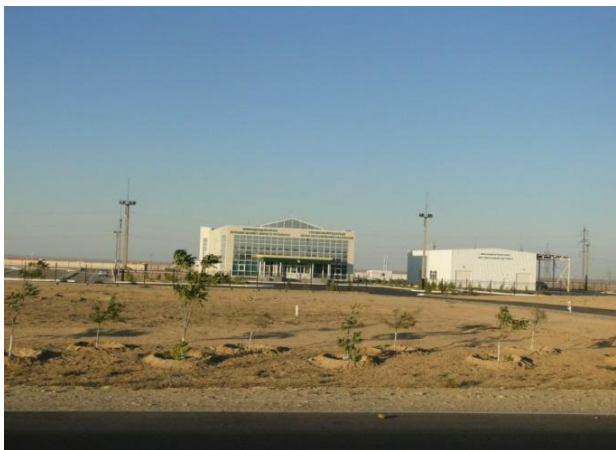
Рисунок 3 – Здание ЦОНа в 600 м от озера
