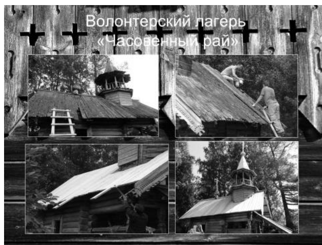
Ил. 6. Фото объекта после консервационных работ «Часовня пророка Илии, 1801-1804 гг.» д. Свиное
