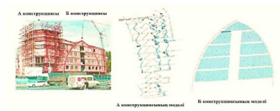
Сурет 6- Жербеттік лазерлік сканерлеу көмегімен құрылысты бақылау
