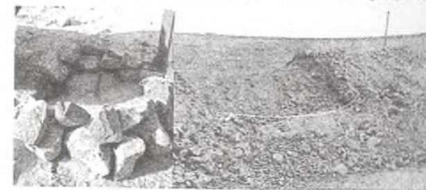
Рисунок 1 - Заложены репера наблюдательных станций
