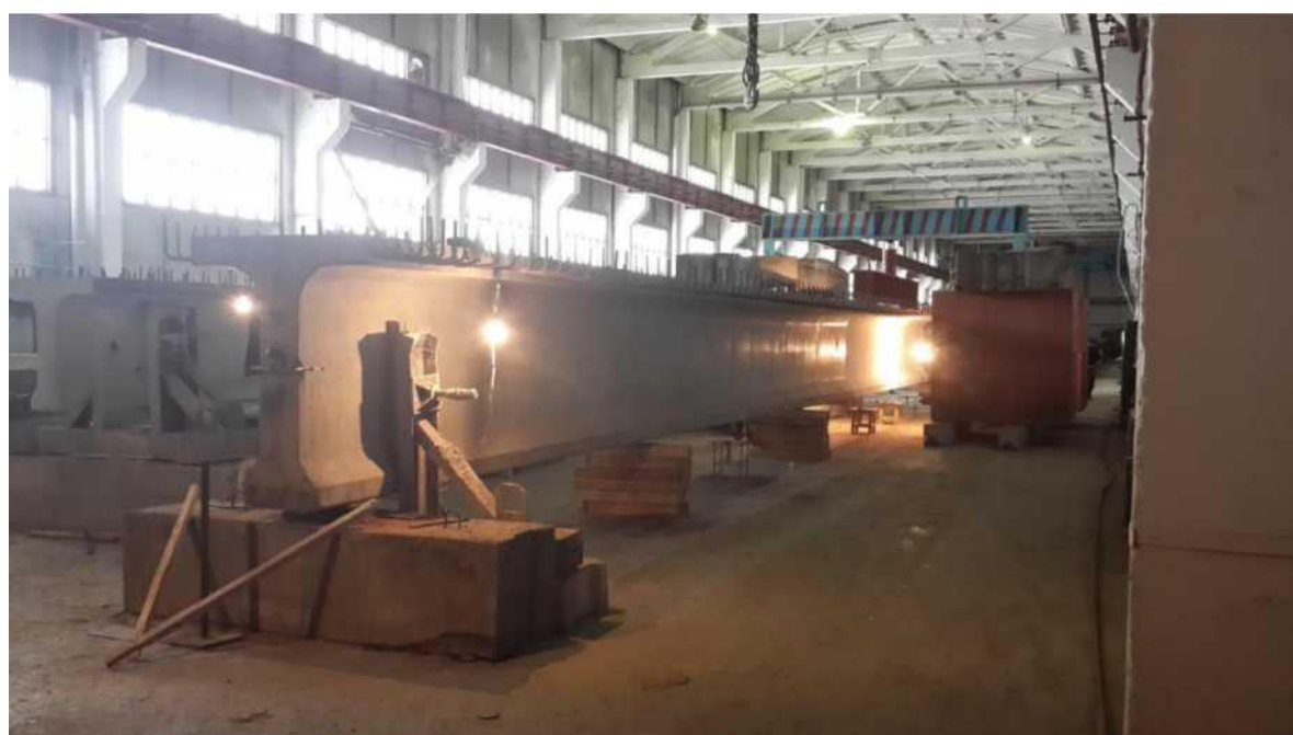
Рисунок 5 - Общий вид мостовой балки во время испытания
