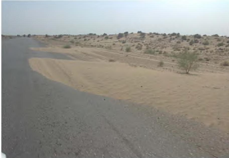
Рисунок 1 – Языковые песчаные заносы на автомобильной дороге
