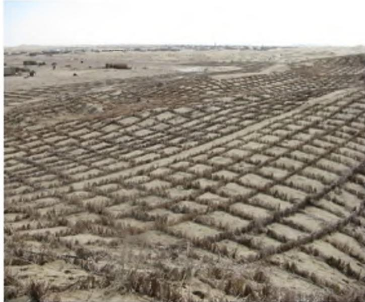
Рисунок 2 – Полная блокировка подвижных барханов клеточными защитами
